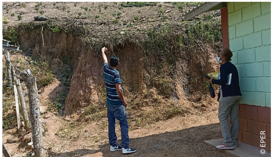
Situés à proximité des habitations, les talus de terre les menacent en cas de précipitations intenses.
